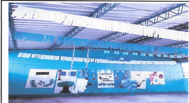
Foto 2: cambio de estructura metalica a techado
