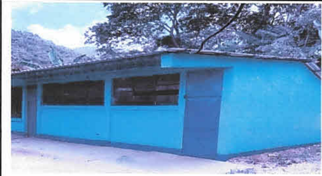
Foto 1: Cambio de techo, por mal estado
